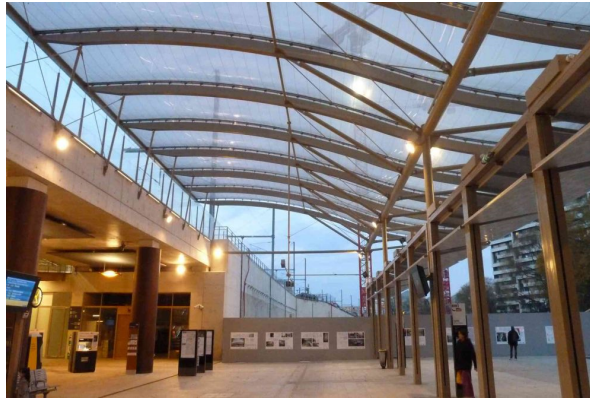
FIGURE 1 – Exemple de couverture en membrane ETFE.
