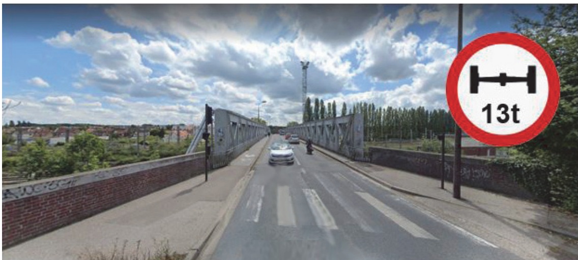
Figure 8 : pont ferroviaire de Longueau
