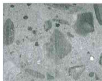
Section d'un béton vue après sciage
